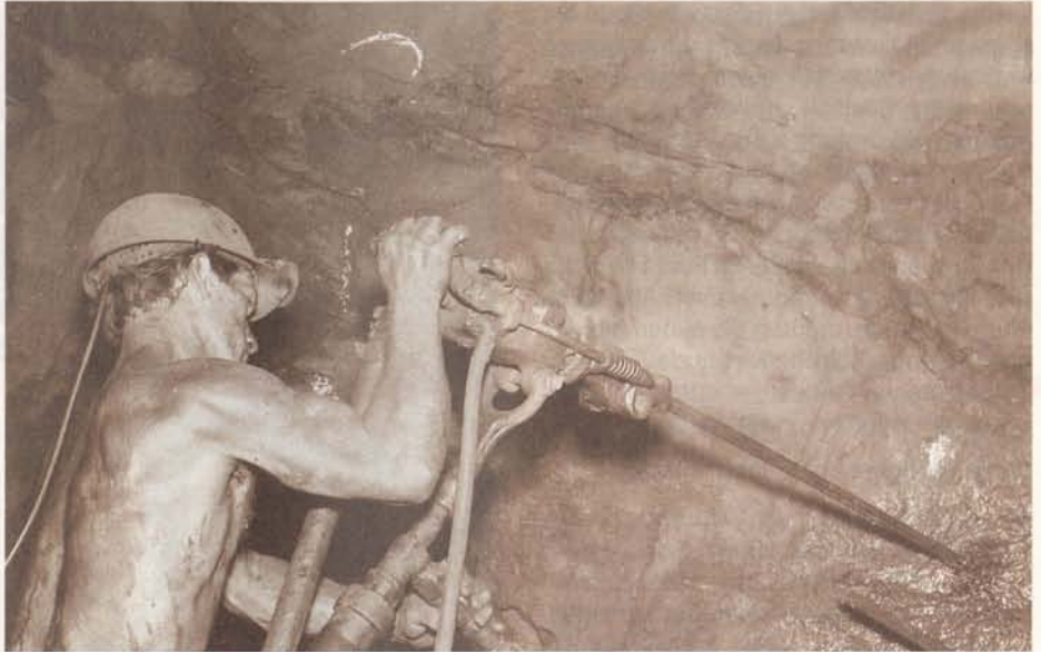
Bild 7: Das Bohren eines Sprengbohrlochs mit einem Preßluftbohrhammer beim Streckenvortrieb auf der 1000-m-Sohle im September 1962. Der Streckenvortrieb erfolgt heute mit Teilschnittmaschinen (siehe Anhang 1).
