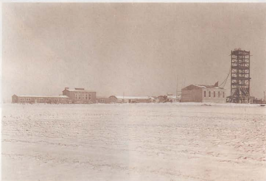
Bild 6: 1957 wurde mit dem Teufen des Schachtes Konrad 1 begonnen. Das Bild zeigt das Teufgerüst über Schacht 1 im Jahre 1958.
