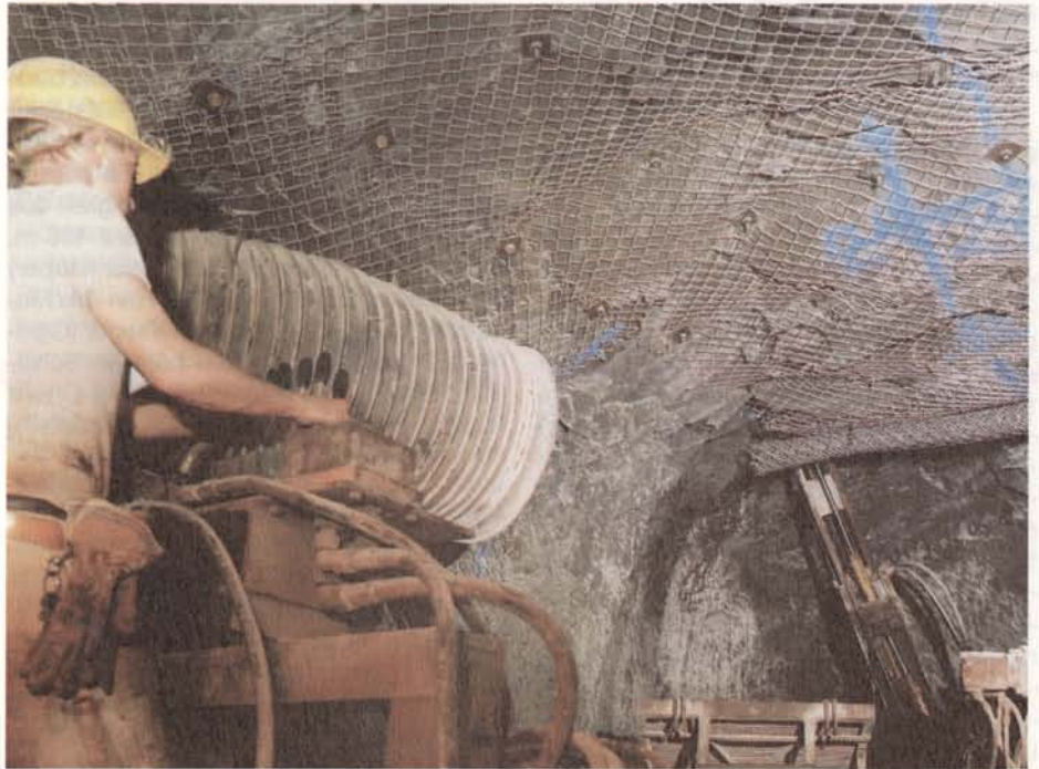
Bild 42: Auf der Teilschnittmaschine ist eine Ankerbohrlafette montiert, mit der die Ankerlöcher gebohrt und die Anker gesetzt werden.
