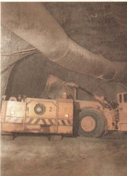
Bild 41: Ein Muldenkipper übernimmt den Transport des Haufwerks bis zur Ladestelle der Schachtförderung.
